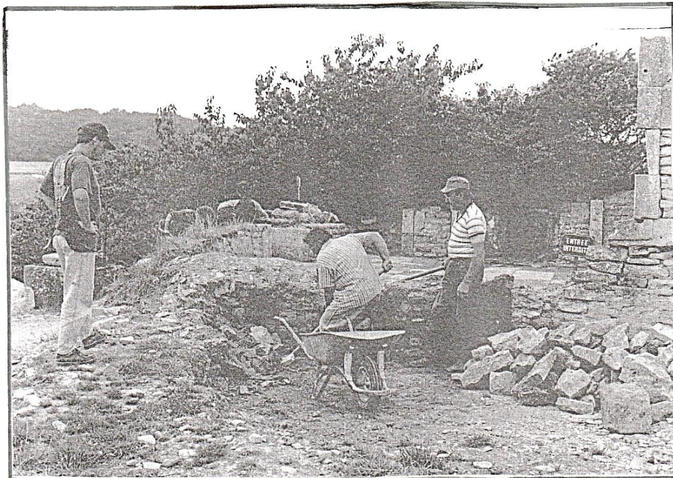
La même salle après : cheminée, bases de fenêtre, évier ont été retrouvés
