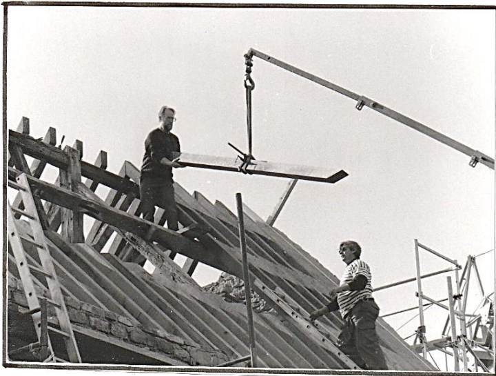
Mise en place des chevrons (en chêne) pente nord du logis (photos 19/9/94)
