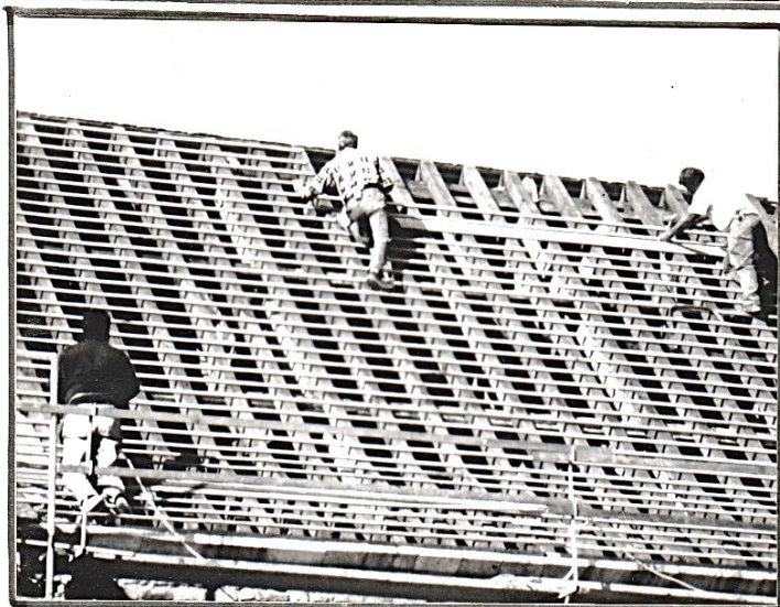
Travaux sur la pente sud (photos 10/10/94)
