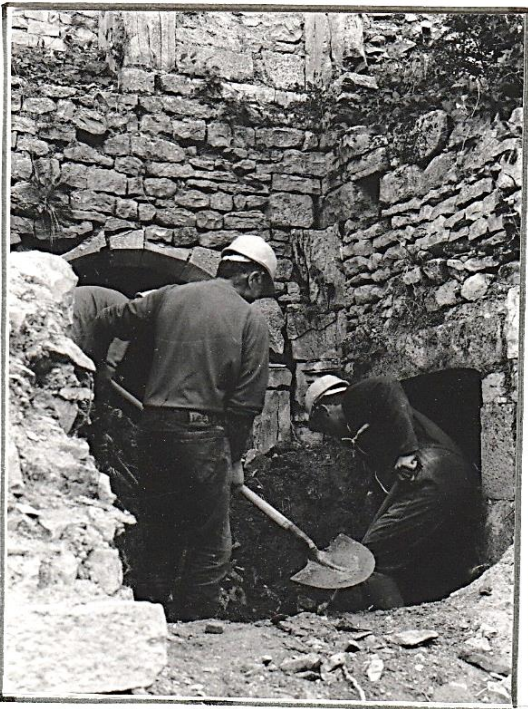
dégagement de l'ancienne salle voûtée niveau 1 de la tour (12/6/93)
