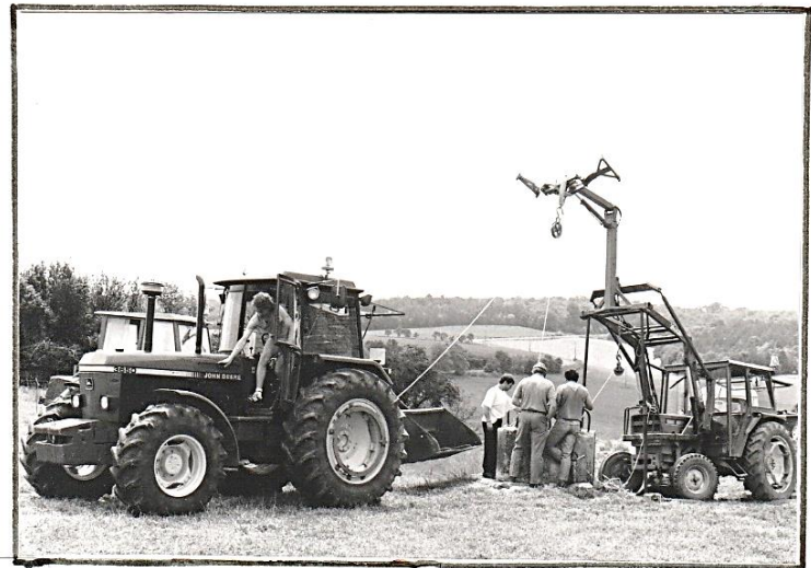
deux tracteurs mis en jeu pour le nettoyage du puits : support de poulie et traction sur le câble (photos 29/5/93)
