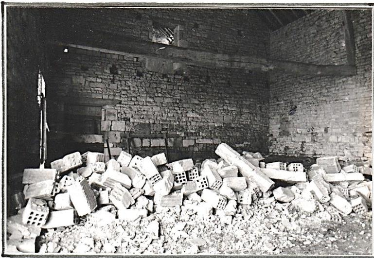
**Aménagement de la grande salle de la grange, le 21/4, après dépose des solives et du plafond : abattage de la cloison de briques.**
